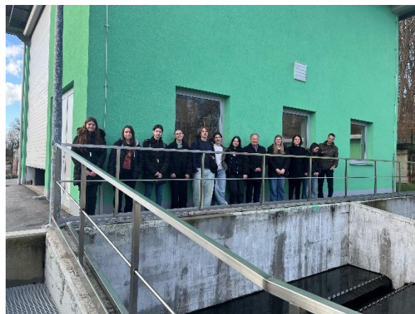
Slika 8: Ogled čistilne naprave
