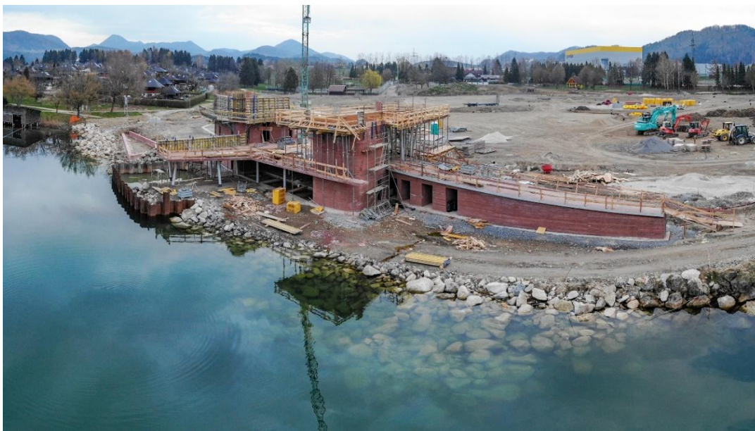
Slika 3: Vista med izgradnjo.
