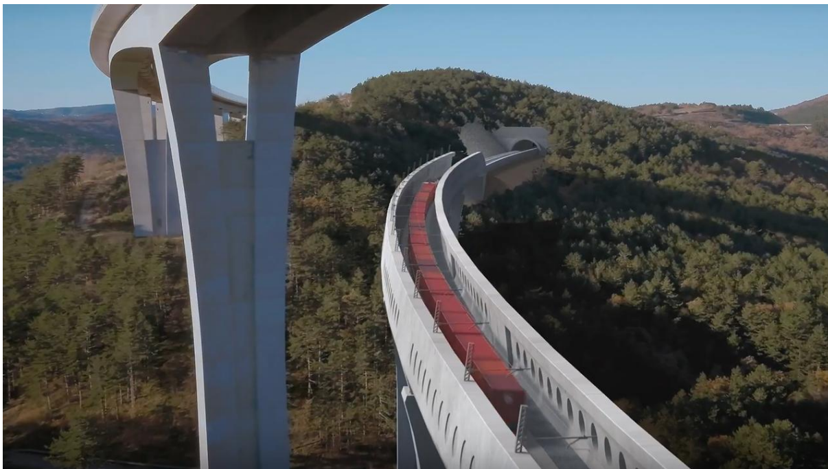
Slika 3: Viadukt Gabrovica, vir: https://www.regionalobala.si/novica/celoten-drugi-tir-bo-gradil-kolektor-v-sodelovanju-s-turskima-podjetjema-yapi-merkezi-in-ozaltin
